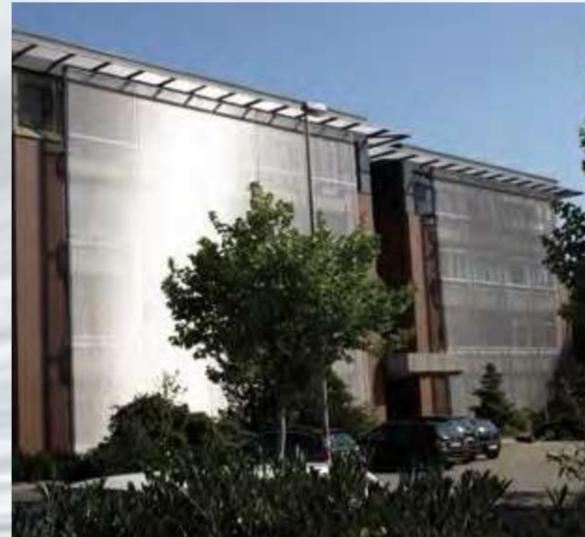
La tela metálica DOGLA-TRIO unifica visualmente la planta nueva, que se ha añadido al edificio, con la construcción antigua. Haver & Boecker, Oelde, Alemania, DOGLA-TRIO 1030.
