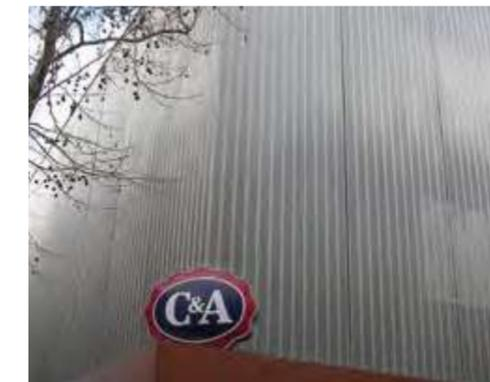
Tela de acero inoxidable semitransparente LARGO-NOVA 2017 cubre la construcción existente y proporciona una iluminación natural. C&A, Mainz, Alemania.
