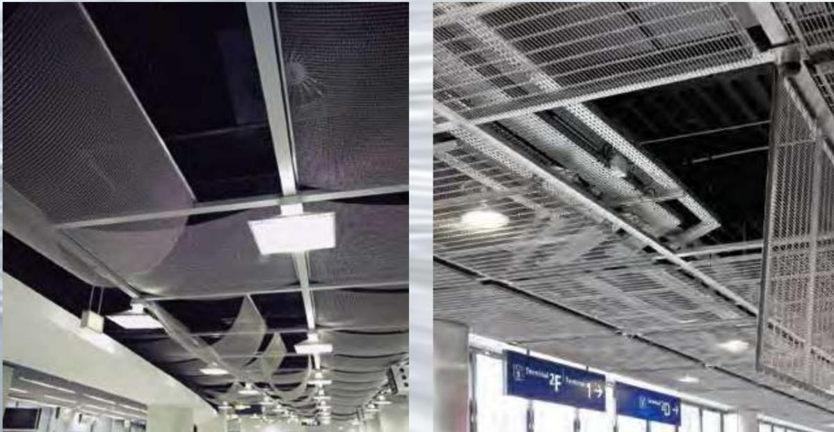
Sistemas de fijación desmontables para techos con caída.
